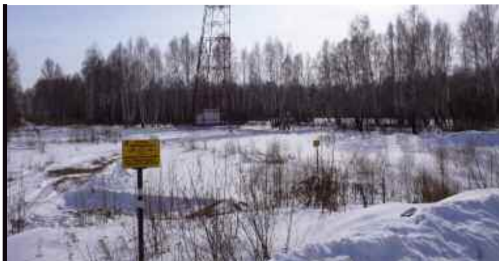
2 Столбики-аншлаги показывают место прохождения подземного линейного объекта
