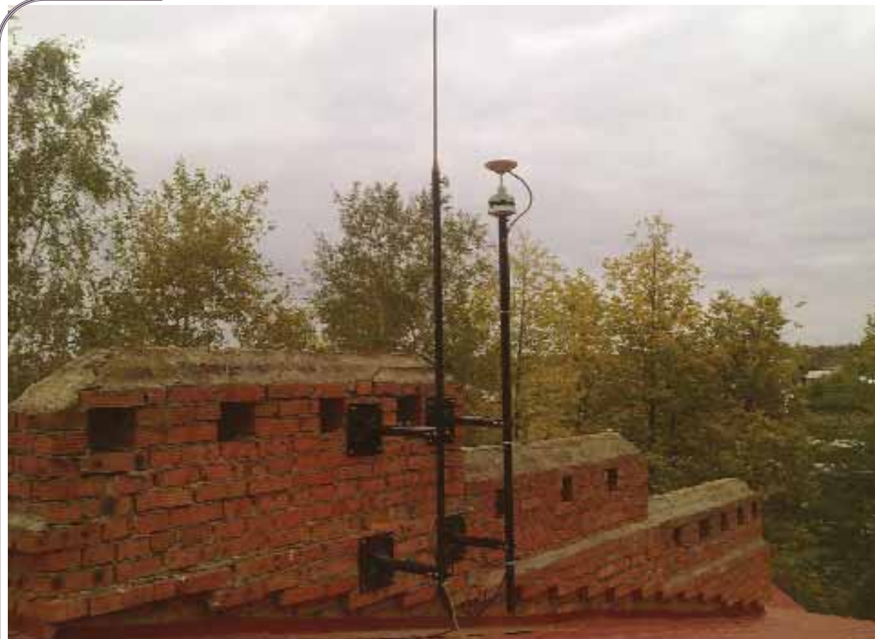
Рис. 2. Общий вид антенного устройства референчной станции
